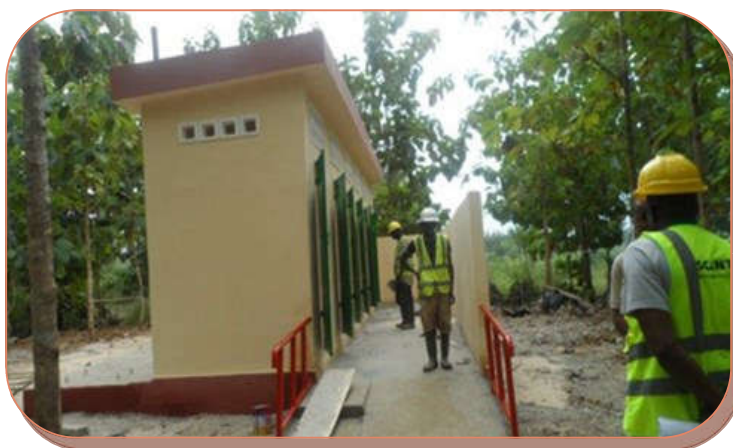
Le bloc de latrines terminé
