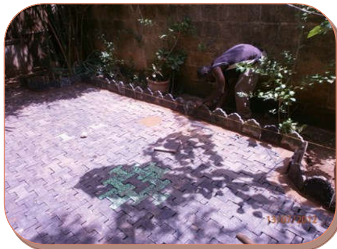
Parterre de pavés plastiques avec bordures
