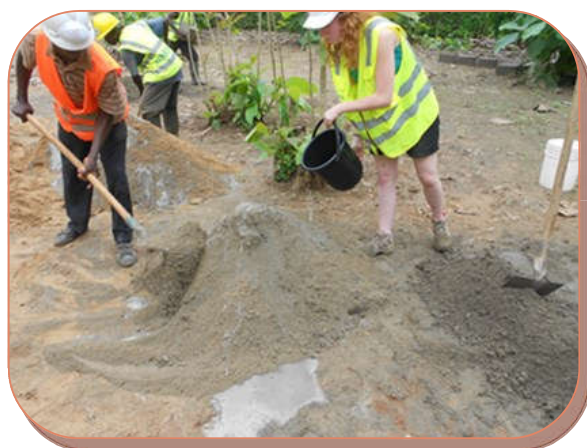
Les étudiants fabriquent le ciment
