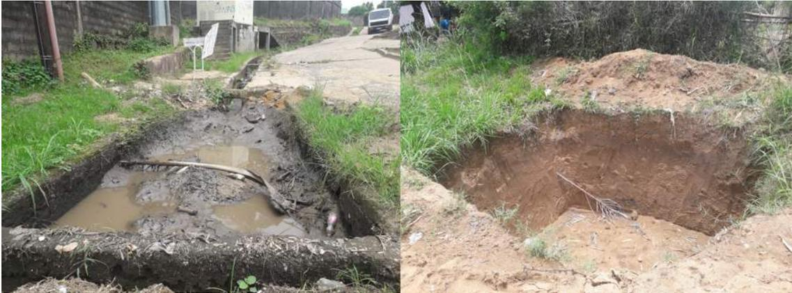
FIGURE 8: *Bassins de rétention dans la commune de Lemba (Kinshasa). A gauche : bassin de rétention en béton rempli de sédiments dans lequel se déversent les eaux canalisées le long d'une route. A droite : bassin de rétention creusé le long d'une route.*
