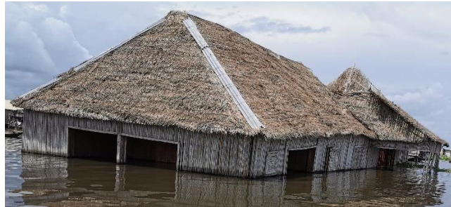
Figure 9: Maison de la francophonie et problème structurel
