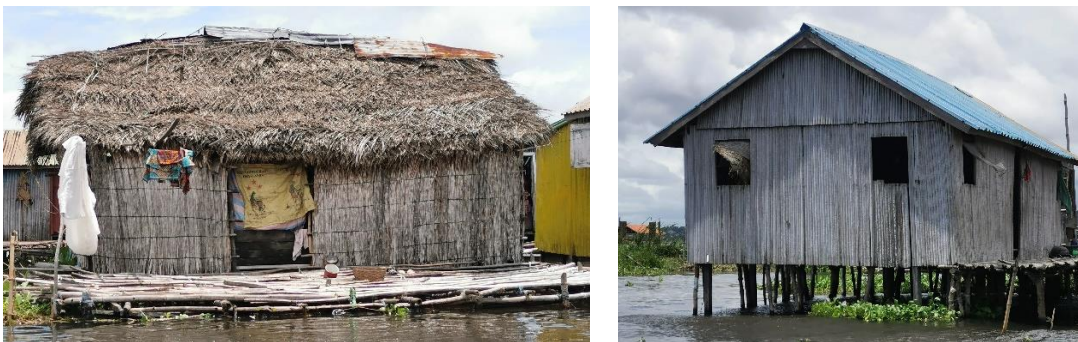
Figure 10: Maisons sur pilotis
