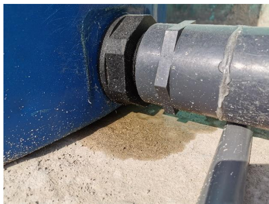
Figure 33: Fuite de liquide entre la cuve et l'écrou du tuyau d'alimentation
