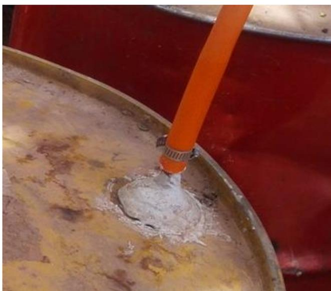
*Figure 35 : Masticage des bouchons des barriques du digesteur modulable*
