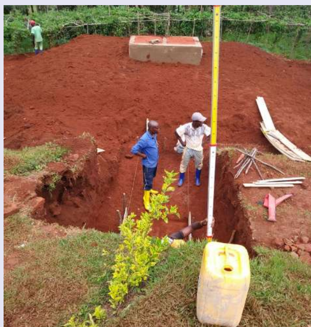
Citerne à 2 compartiments en cours d'enfouissement
